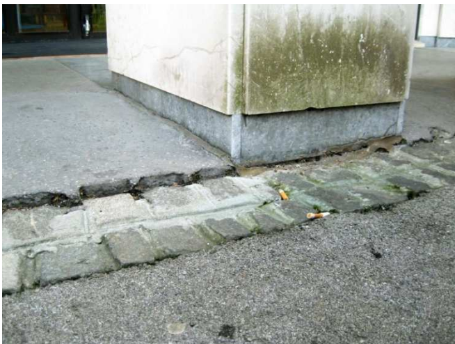
Neustrezna izvedba zasipov
