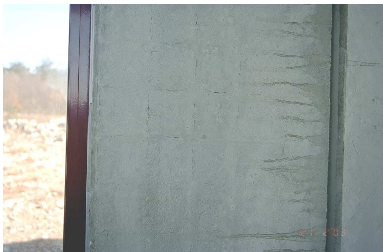
Premajhna debelina krovne plasti betona nad armaturo v AB elementih
