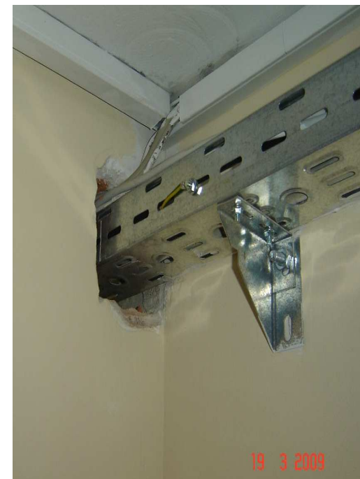
Preboj v požarni steni
