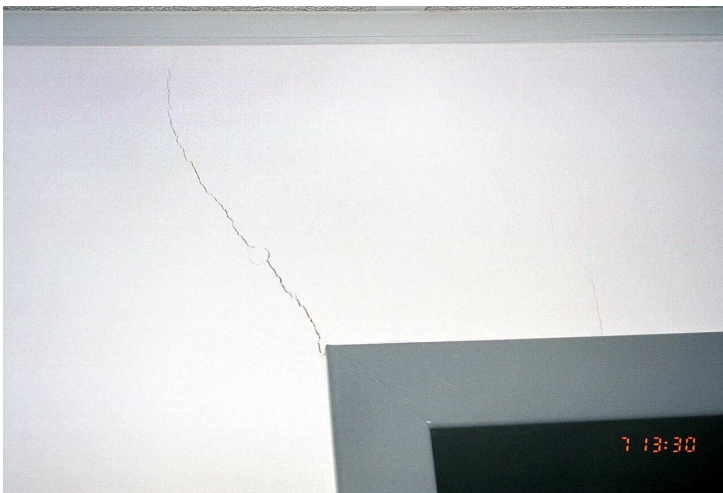
Neustrezna zasnova konstrukcije
