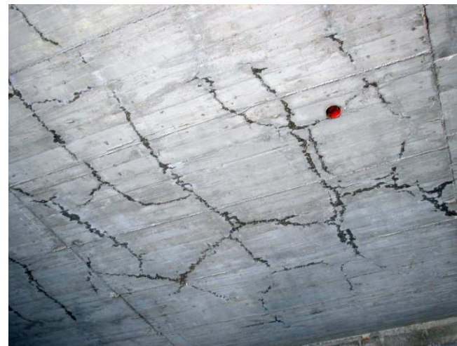
Pomanjkljiva nega betona
